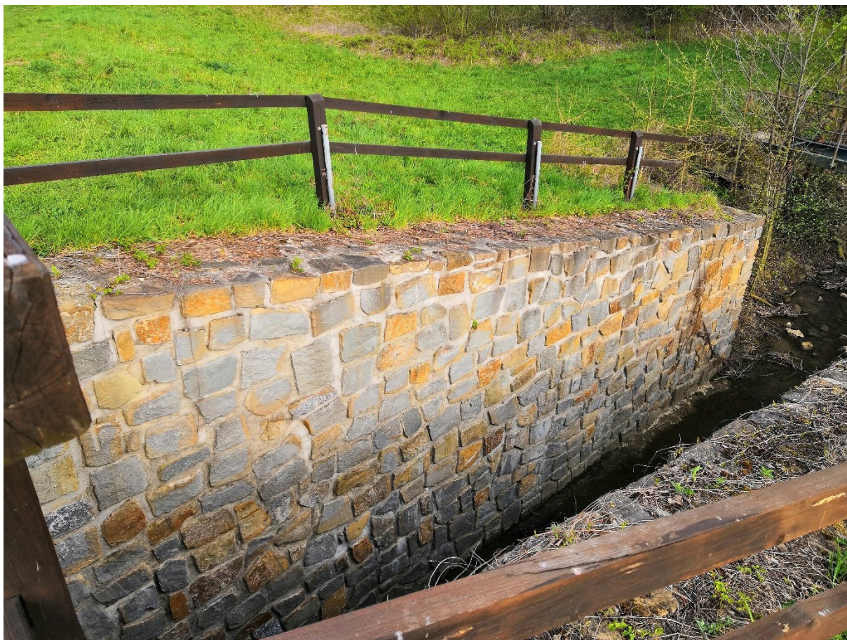
Hráz oddělující horní tok Salašky od Velehradu se zářezem koryta Salašky s průtočným profilem
